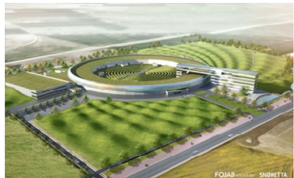
Figur 2. Skitse af den kommende røntgenkilde, MAX IV, med bølgede jordvolde omkring. Jordvoldene dæmper rystelser, så maskinen virker bedst muligt. Elektroner accelereres i en lineær accelerator, som ikke ses på billedet. Elektronerne sendes derefter ind i forskellige ringe, hvor de holdes i cirkelbevægelse ved hjælp af magnetfelter. På særlige steder får de kraftige sidelæns "skub" og udsender som reaktion herpå en fremadrettet røntgenstråling. Røntgenstrålingen benyttes til materialeundersøgelser.
